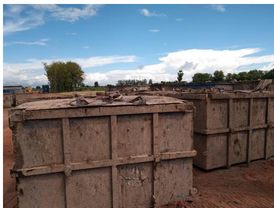
ภาพถ่ายที่ 2.2-3 เศษดินเศษหินในกล่องเหล็ก (Lugger Box) และมีวัสดุปิดคลุม
