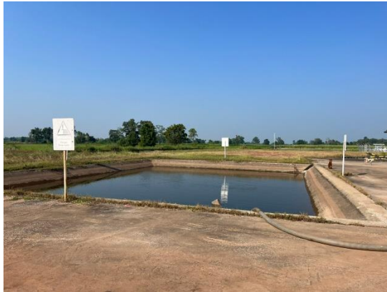
ภาพถ่ายที่ 2.2-7 บ่อคอนกรีตเก็บน้ำ (Concrete Pit)
